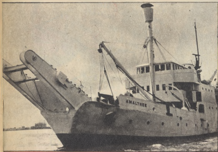
A L'AVANT, « AMALTHÉE » SE CARACTÉRISE PAR SES DEUX ÉNORMES DAVIERS DE LEVAGE
